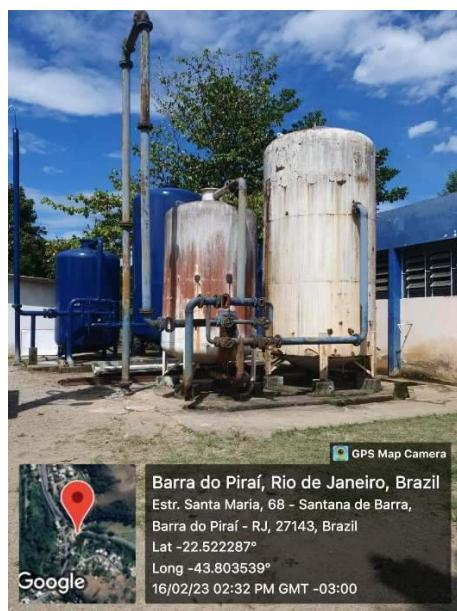
**Figura 96 – Sede – Subsistema ETA Parque Santana - ETA: Floculador/decantador e filtro**
