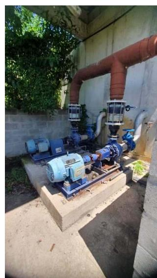
**Figura 183 – SES Califórnia da Barra – ETE Califórnia da Barra: Soprador**
