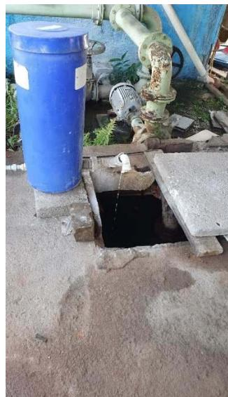
**Figura 48 – Sede – Subsistema ETA Matadouro - ETA: Conj. motor-bomba de lavagem dos filtros**
