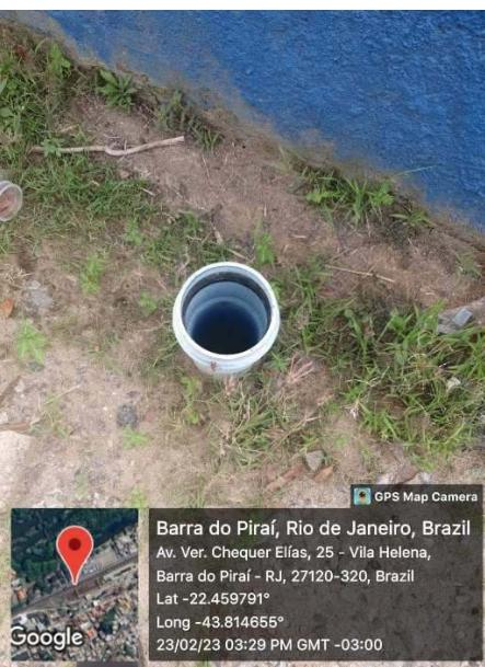
**Figura 169 – Sede – Subsistema ETA Vila Helena – Registro de manobra sem caixa de proteção e soterrado**
