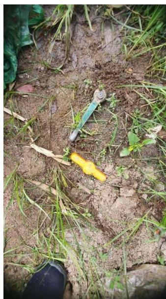
**Figura 168 – Sede – Subsistema ETA Vila Helena – Registro de manobra sem caixa de proteção**
